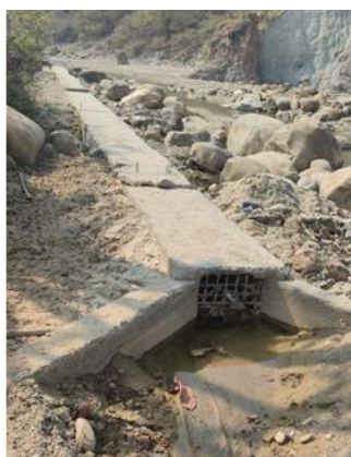
चित्र ११: फलामे जाली (Trash Rack) नियमित सफा गर्नुपर्दछ
