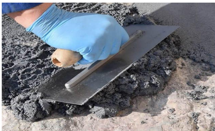
चित्र १३: कंक्रीट संरचनामा भएको क्षतिको मर्मत कार्य
