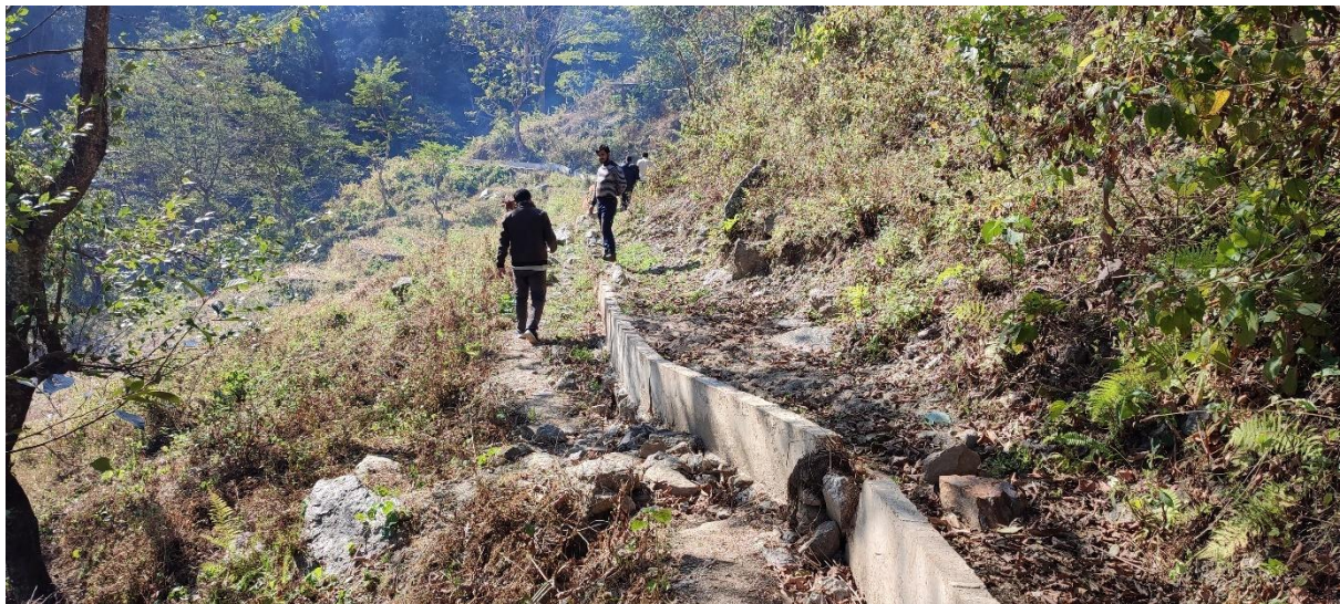
चित्र १९: पक्की कुलो समयमा मर्मत नभए भत्कने क्रम बढ्दै जान्छ
