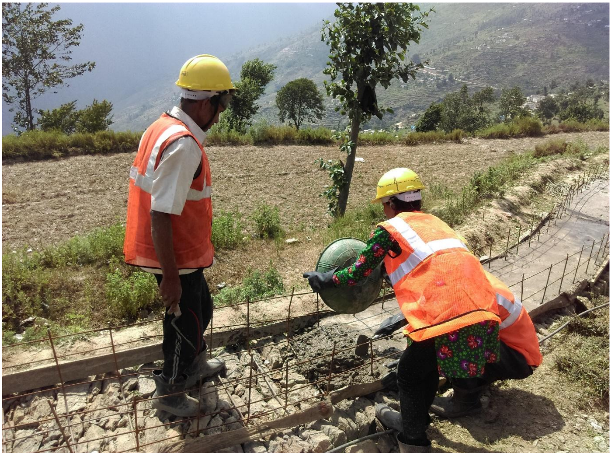
चित्र १८: कुलो पक्की गर्ने कार्य
