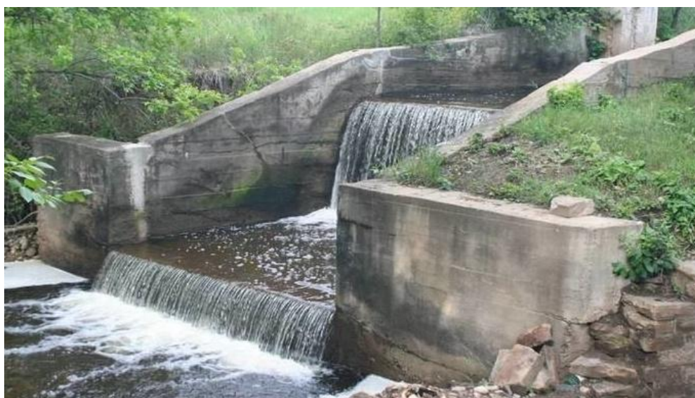
चित्र २३: ड्रप संरचनाको कंक्रीट वा जोडाइमा देखिएको क्षति समयमै मर्मत गर्नुपर्दछ
