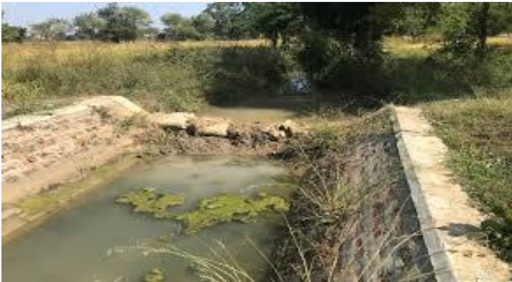
चित्र १६: कुलोभित्र छेकबार लगाउनाले भएको क्षति
